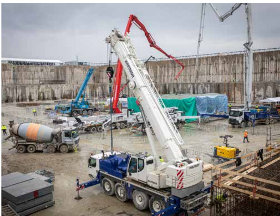
Betonöntés az ötös blokk területén
