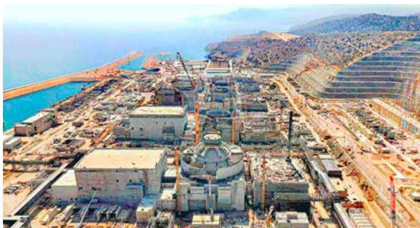
Az épülő Akkuyu Atomerőmű
