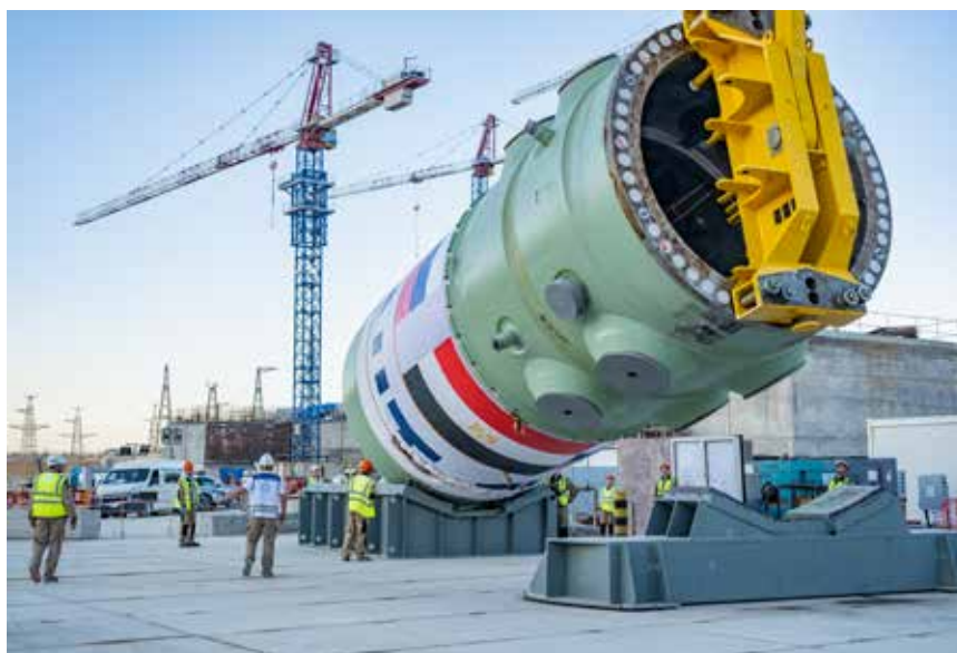
Az egyiptomi El Dabaa Atomerőmű első, VVER-1200 típusú reaktortartálya
