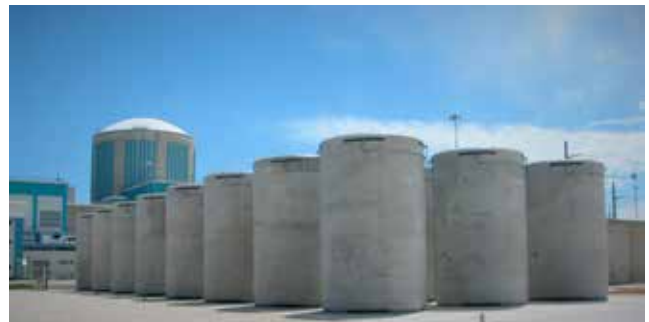
Egy száraz technológiával működő kiegészítőüzemanyag-tároló létesítmény
